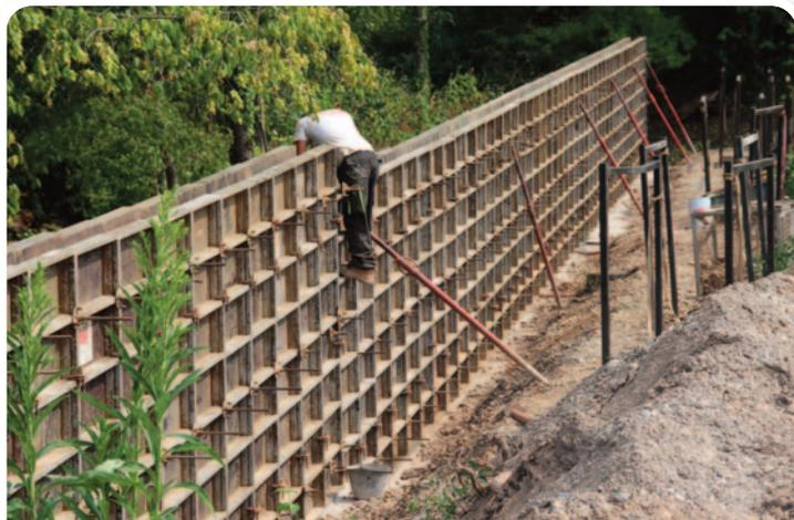
Aménagement de l'accès à la rue au futur lotissement du Clos Dali par la création d'un mur de soutènement en béton banché pour élargir la rue.
