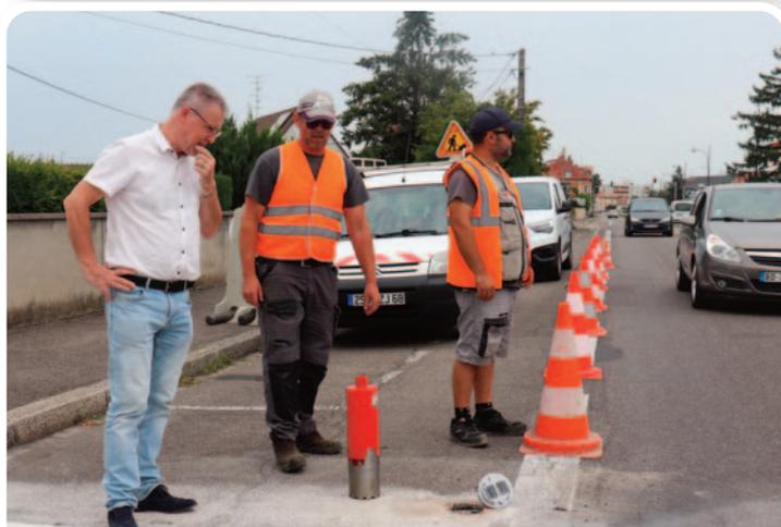
Pose de plots lumineux LED photovoltaïques clignotants au niveau de plusieurs passages piétons pour renforcer la sécurité des usagers en fin de journée et la nuit.
