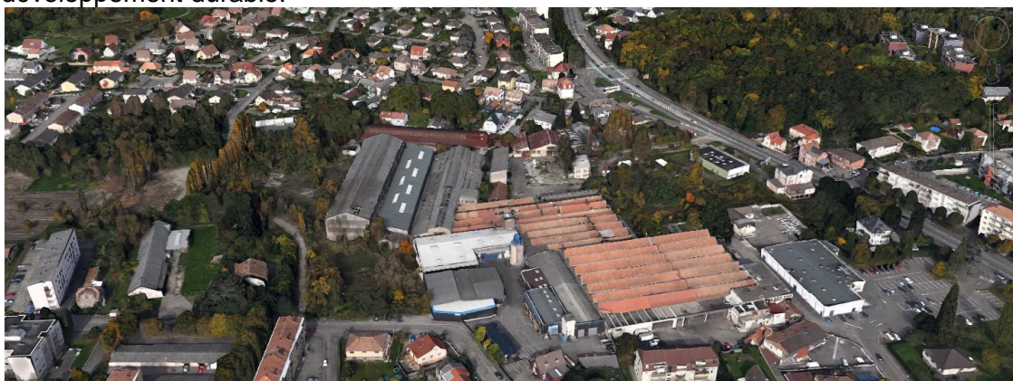
La friche industrielle AMECO (2-AU), site stratégique aux confins du ban.
