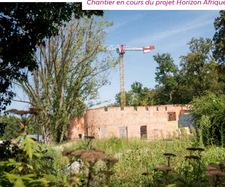
Chantier en cours du projet Horizon Afrique
